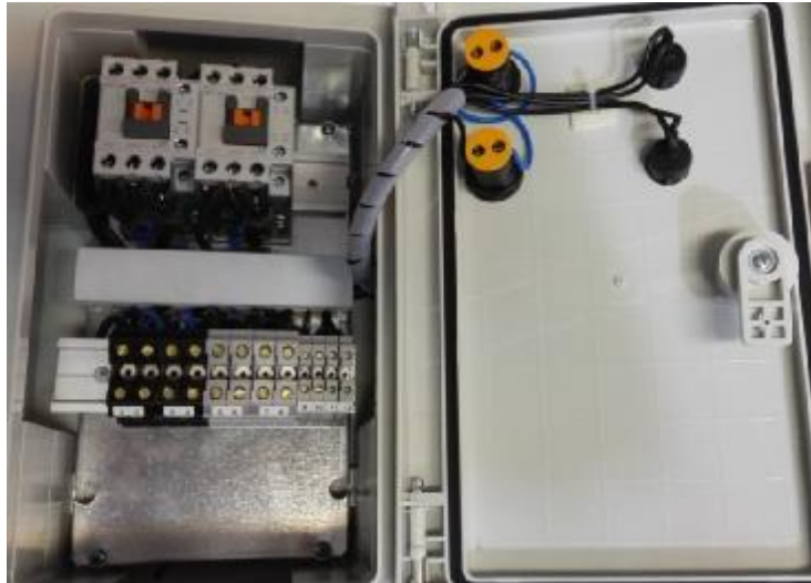
شکل 11: نمای داخلی باکس قدرت
